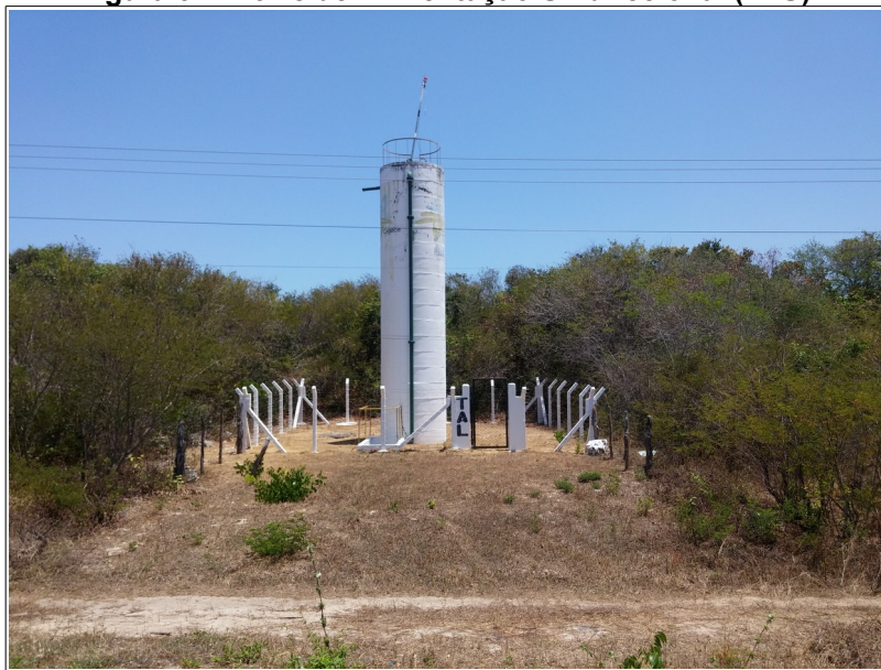
Figura 5.7: Torre de Alimentação Unidirecional (TAU).
